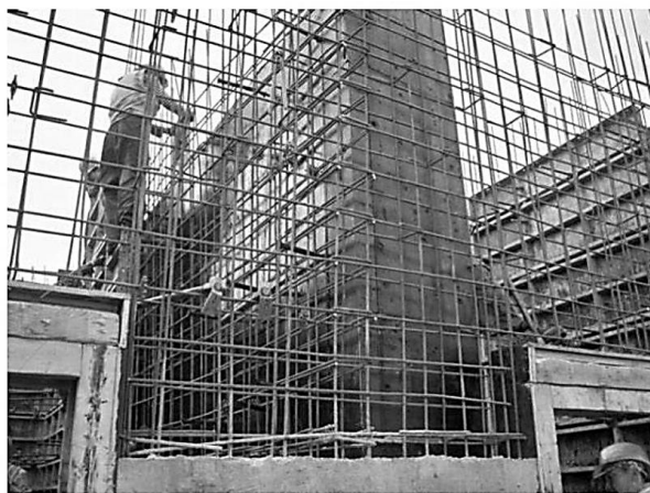
Рис. 2. Вязка каркаса стены монолитного дома 1
