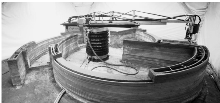
Рис. 5. Печать стен здания на 3D-принтере в Подмоскowie 1
