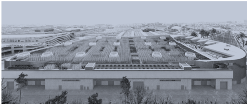
Рис. 1. Городская ферма Agripolis в Париже (Франция) (архитектурное бюро Valode & Pistre Architects)
